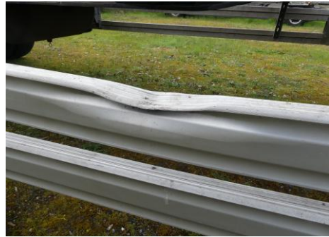
Unterfahrschutz rechts verformt
