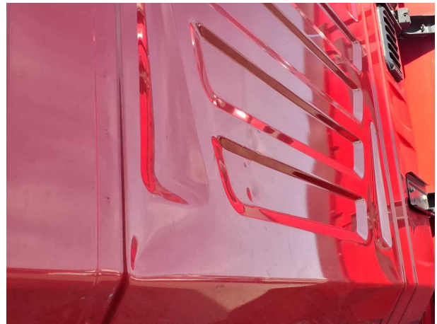
Beschädigung 17: Fahrerhaus: Rückwand - verformt - instandsetzen und lackieren
