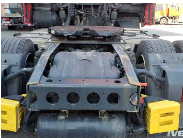
Beschädigung 10: Rahmen: Längsträger rechts (verformt, links und rechts) - Korrosion - instandsetzen und lackieren
