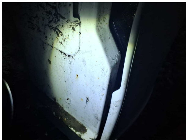
Beschädigung 15: Anbauteil rechts: Einstieg unten - gebrochen / gerissen - erneuern
