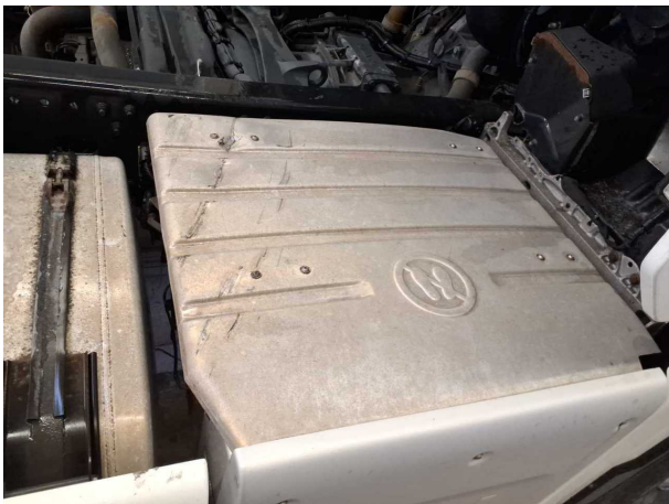
Beschädigung 11: Abgasanlage: Hitzeblech - verkratzt / verschürft - erneuern
