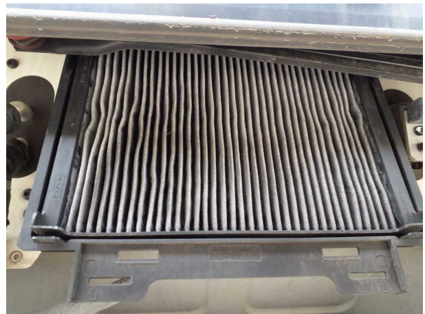
Beschädigung 6: Heizungssystem: Innenraumfilter - verschmutzt - erneuern
