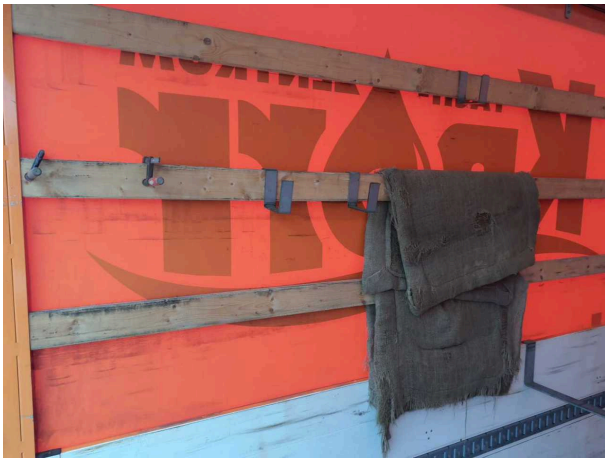
Beschädigung 4: Aufbau: Aufbau - verschmutzt - reinigen
