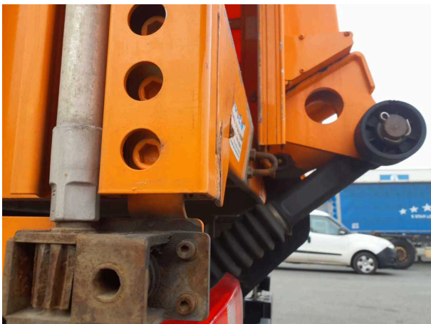
Beschädigung 9: Rahmen: Rahmen (Aufbau hinten unten) - verformt - instandsetzen und lackieren
