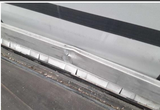
Einsteckplatte verformt
