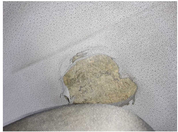
Beschädigung 20: Fahrerhaus: Rückwandverkleidung - beschädigt - erneuern
