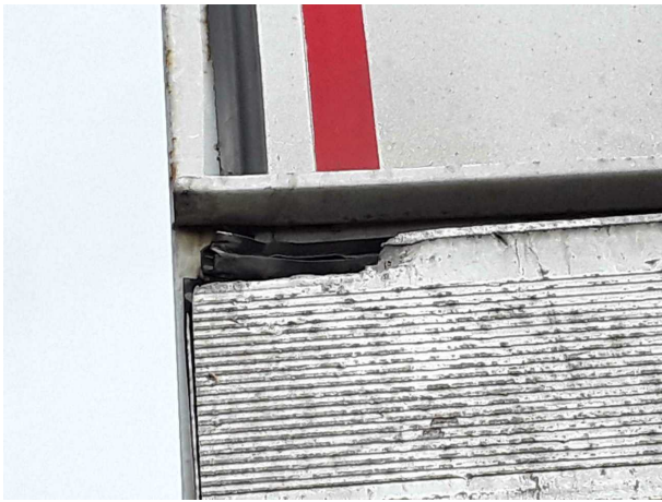
Beschädigung 14: Ladebordwand: Blatt - gebrochen / gerissen - instandsetzen
