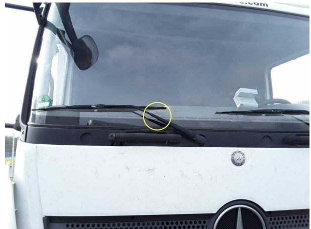
Beschädigung 22: Verglasung: Frontscheibe - Steinschlag - erneuern
