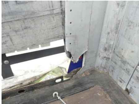
Eckrunge vorne links gebrochen/gerissen
