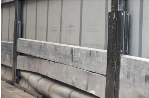
Einstecklatten verformt
