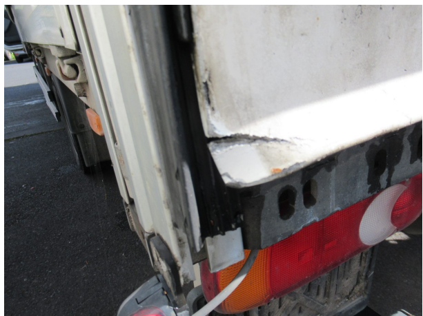
Beschädigung 10: Ladebordwand: Ladebordwand - gebrochen / gerissen - instandsetzen und lackieren
